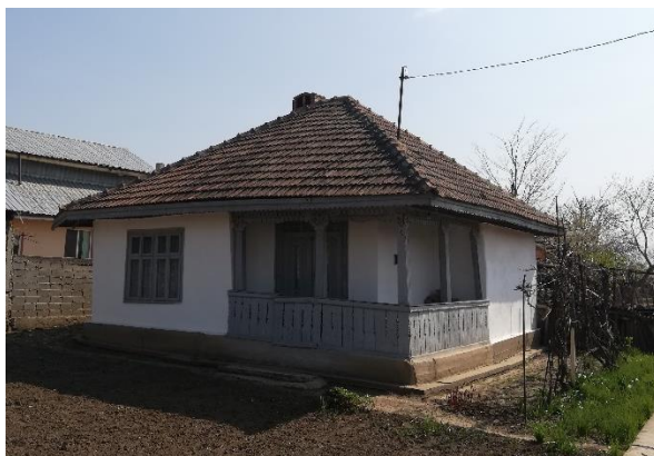
Figură 23 – Locuință cu structură monobloc cu prispă pe latura principală și cu parapet din lemn
