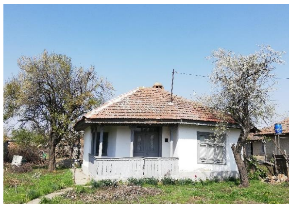
Figură 16 – Acoperiș cu țiglă ceramică
