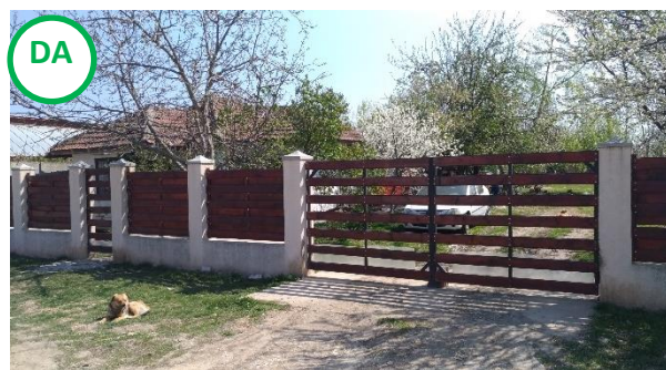
Figură 10 – Tipologii de împrejurări specifice în Comuna Roșiori – locuință cu împrejurarea din lemn orientat pe orizontală cu o structură de stâlpi și soclu din beton
