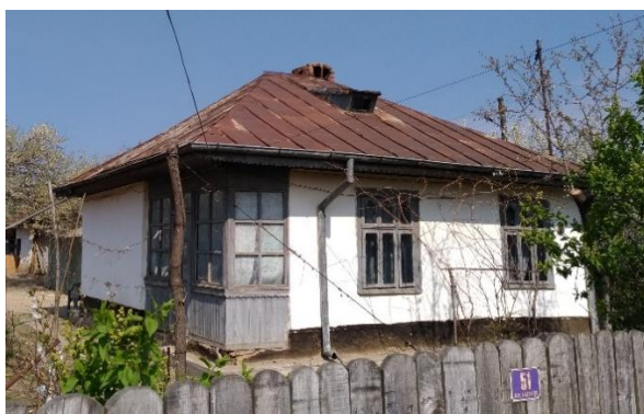
Figură 25 – Locuință cu structură monobloc cu prispă închisă cu tâmplărie de lemn și geamuri
