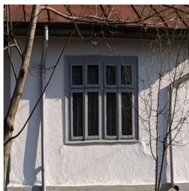
Figură 29 – Fereastră cu patru canaturi divizate cu ochiuri cu formă pătrată
