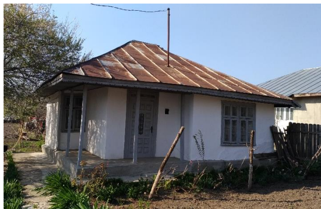
Figură 24 – Locuință cu prispă deschisă prezentă pe două laturi ale locuinței și structură cu stâlpi de lemn
