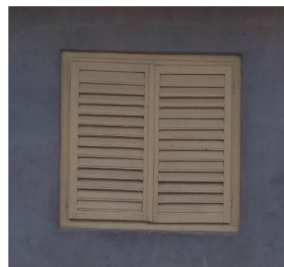
Figură 31 – Fereastră cu tâmplărie de lemn formată din două canaturi și obloane verticale
