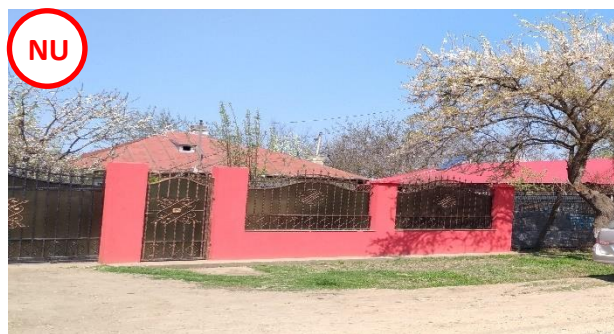
Figură 9 – Tipologii de împrejurări specifice în Comuna Roșiori – clădire de locuit. Se poate observa împrejurarea din fier forjat dublat de panou opac și soclu și stâlpi din beton
