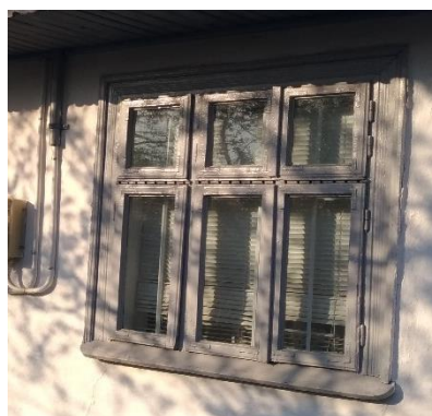
Figură 30 – Fereastră cu trei canaturi divizate în ochiuri cu formă pătrată
