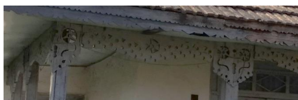
Figură 33 – Element traforat regăsit la nivelul șarpantei
