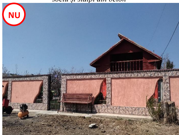
Figură 11 – Tipologii de împrejurări specifice în Comuna Roșiori – locuință cu împrejurarea din beton și inserții de fier forjat ce indică goluri de transparență într-un mod necorespunzător, ce nu se încadrează în specificul locului
