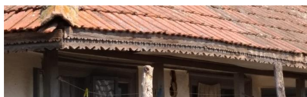
Figură 34 – Element traforat regăsit la nivelul șarpantei
