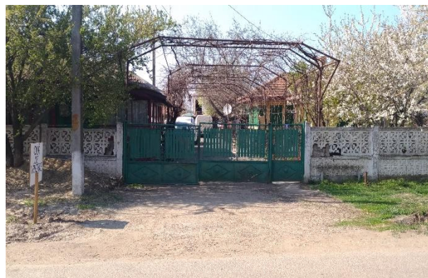
Figură 5 – Tipologii de împrejurări specifice în Comuna Roșiori - Împrejurări cu stâlpi și plăci prefabricate din beton cu decorațiuni și poartă din elemente metalice, clădire de locuit
