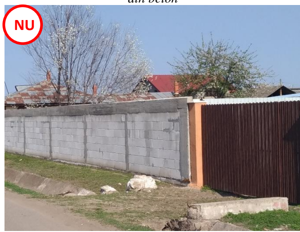
Figură 12 – Tipologii de împrejurări specifice în Comuna Roșiori – locuință cu împrejurare din BCA pe cadre de beton ce nu se încadrează în tipologia specifică zonei – nici prin material, nici prin redarea unei transparențe parțiale
