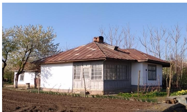
Figură 26 – Locuință cu structură monobloc cu prispă închisă din lemn și închideri cu geam
