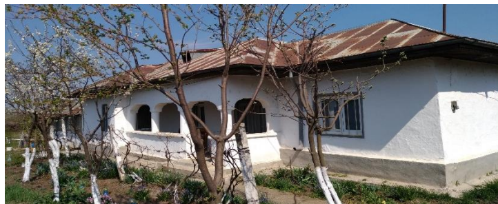
Figură 28 – Locuință cu antreu – pridvor central deschis și cu elementele exterioare din cărămidă/ beton – scări, soclu, parapet, stâlpi
